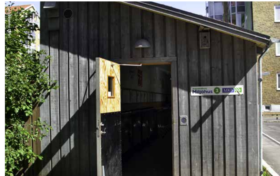
I bostadsområdet finns 13 olika miljöhus, med eller utan fönster, där hushållen kan sortera förpackningar av papper, plast, glas, metall, tidningar och matavfall.
