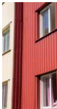
Ny fasad i profilerad plåt.
