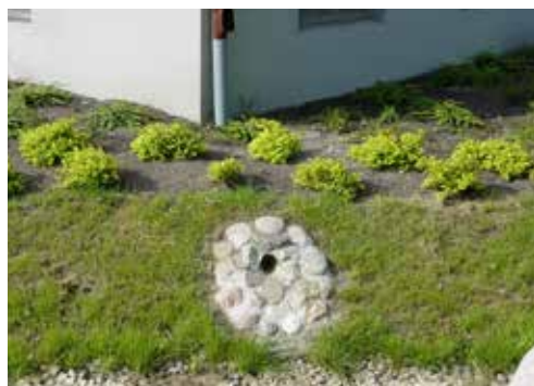
Bild 9. I etapp 2, det norra stråket, är det inte lika tydligt att stuprörsvattnet leds ut ovan mark.
