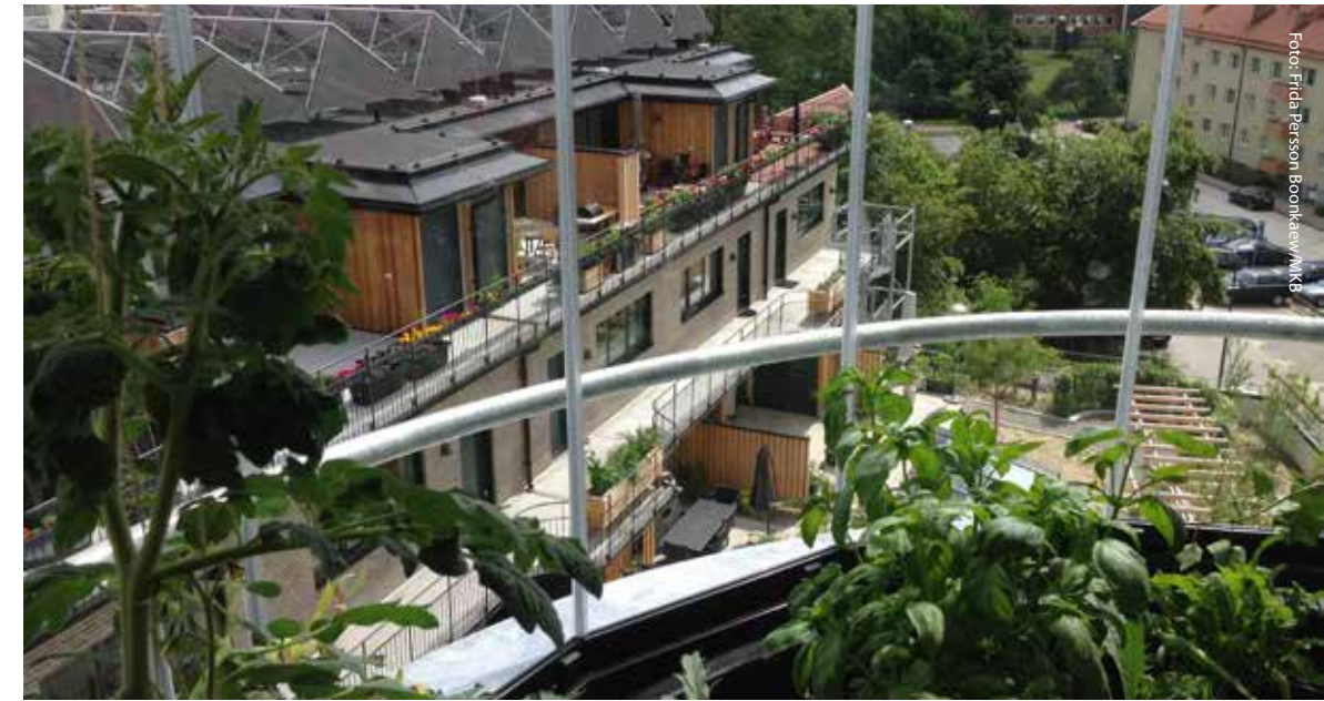
Lägenheterna i Greenhouse är utrustade med stora odlingsbalkonger.
