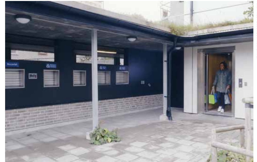
Miljöhuset i Greenhouse Augustenborg.
