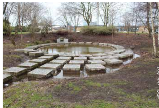
Bild 5. Längst ner i systemet finns en stor fördröjningsvolym, en damm. Bräddutlopp till ledningsnätet i gatan utanför syns i bortre änden av dammen. Bilden är tagen 2016 strax efter att omgivande växtlighet rensats och klippts ner
