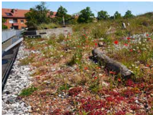
Taken utvecklas ständigt. Här ser ni det så kallade ruderat-taket, fotograferat med tio års mellanrum. En del av kalkstenen har bytts ut till mer vattenhållande substrat.
