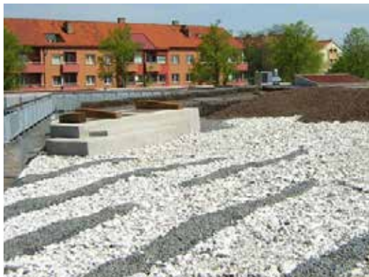
Taken utvecklas ständigt. Här ser ni det så kallade ruderat-taket, fotograferat med tio års mellanrum. En del av kalkstenen har bytts ut till mer vattenhållande substrat.
