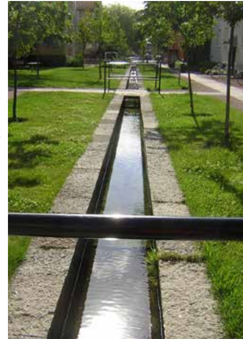
I det öppna dagvattensystemet i Augustenborg färdas vattnet långsamt genom kanaler, diken och dammar, genom grönska och ytor som tål översvämningar.
