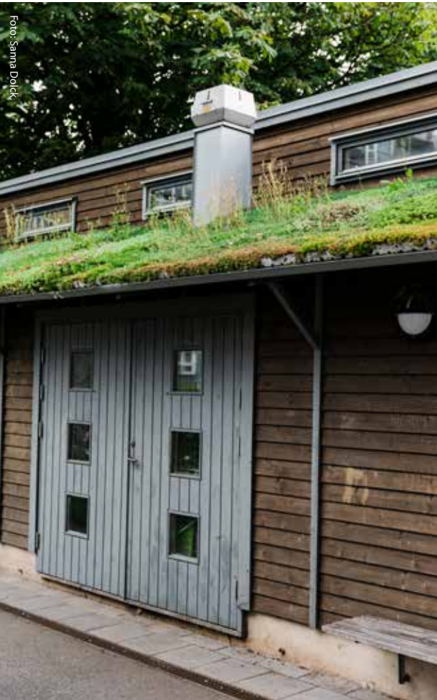
Ett av miljöhusen i Augustenborg.
