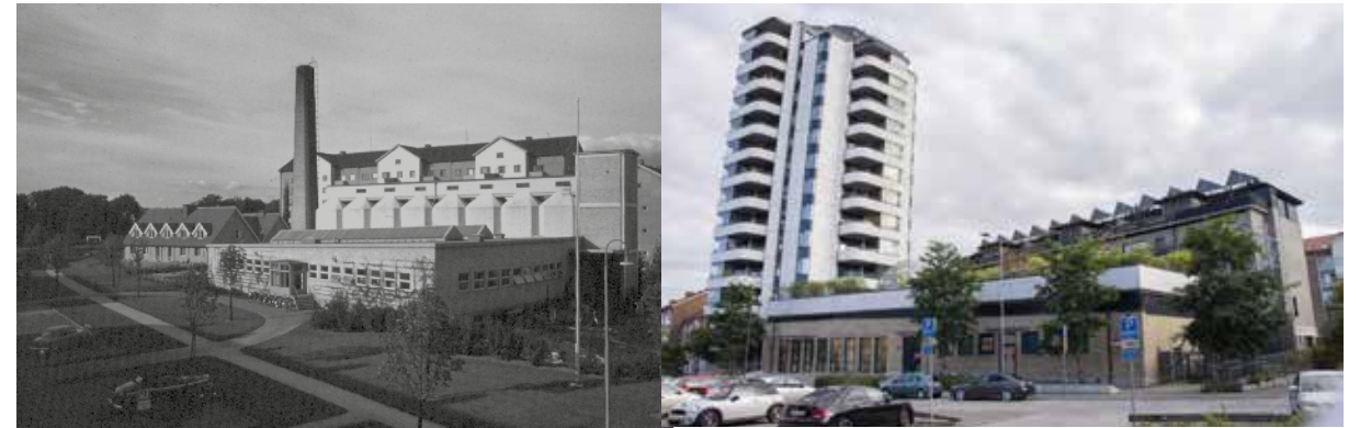
Greenhouse byggdes på platsen där värmecentralen och tvätteriet låg i Augustenborg. Det är ett led i MKB:s strategi urban akupunktur - att "lyfta" ett bostadsområde genom enskilda punktsatser. Foto: MKB.
