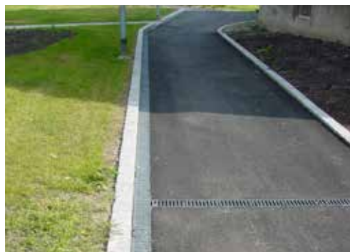
Bild 8. I etapp 2, norra stråket, byttes ränndalarna ut mot gallerförsedda rännor, och gruset mot asfalt.
