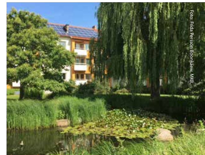
Solceller, en grönstruktur och ett öppet dagvattensystem – kanske inte de mest avancerade innovationerna, men kombinationen och hur väl de har integrerats i området, gör att lösningarna fortfarande väcker stort intresse.
