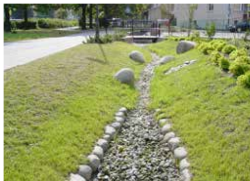
Bild 7. Dagvattendike längs med Lönnngatan. Foto Ulf Thysell. Här användes dessutom gallerförsedda rännor istället för öppna rännor vilket gör att dagvattenhanteringen inte tar lika tydlig plats i stadsrummet, se bild 8.
