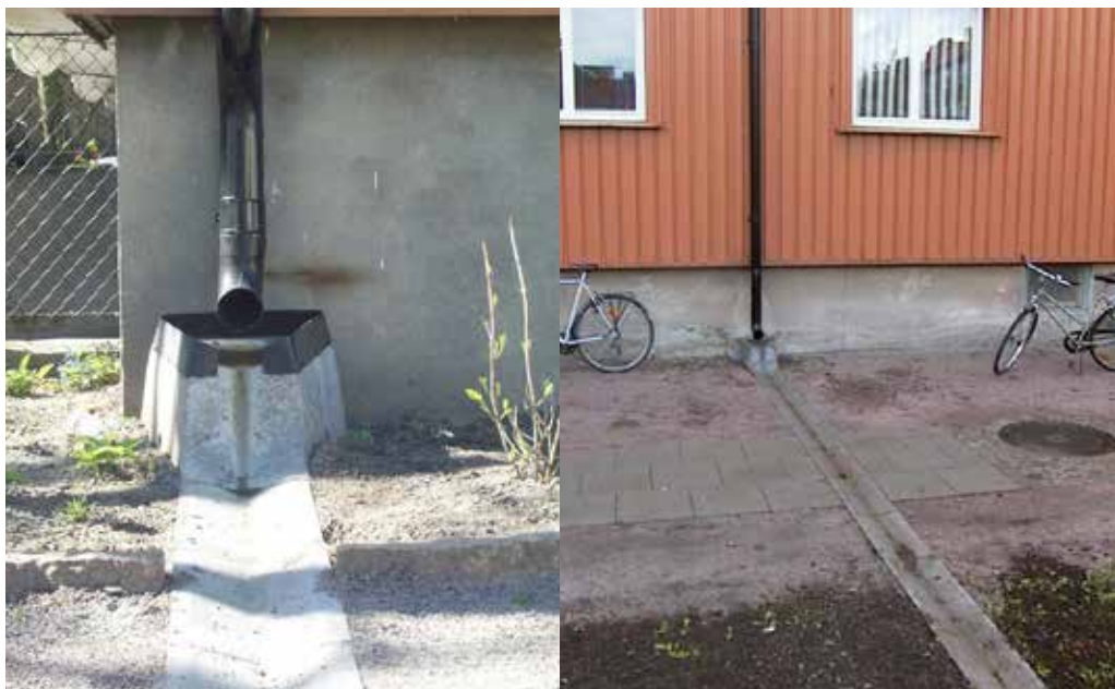
Bild 2. Stuprörsutkastare och rännal i etapp 1, södra stråket.
