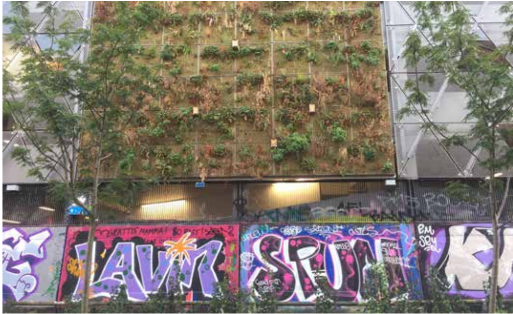
Lärdomarna från Ekostaden Augustenborg om blågröna lösningar sprids i Malmö. Under 2019 ledde ett samarbete med det kommunala parkeringsbolaget Parkering Malmö till att gröna väggar installerades på bland annat parkeringshuset Anna.
